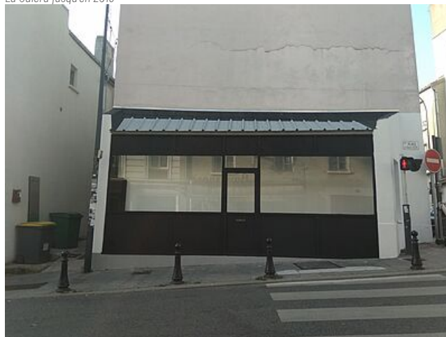
Fin des travaux 2018
